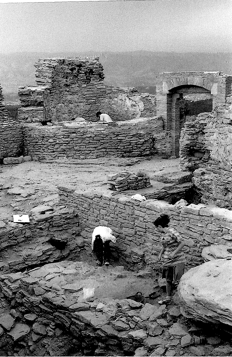
Vista general del recinte abans i després de la seva restauració
