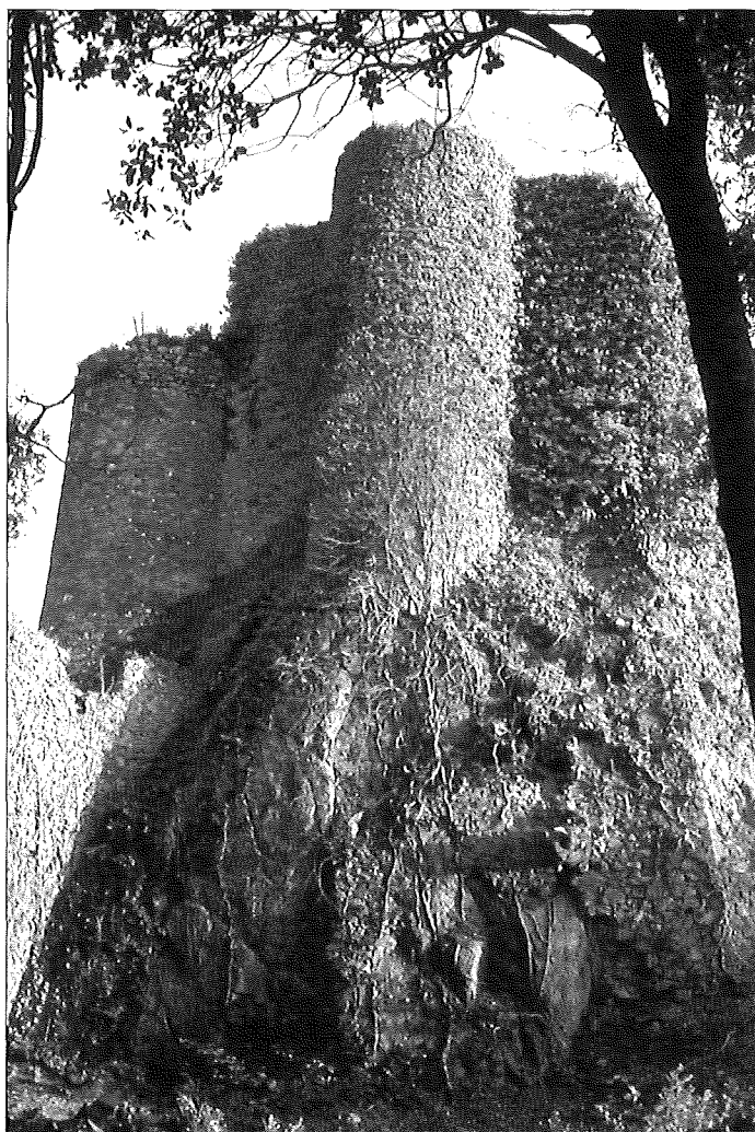
Fossat nord i adarb del recinte sobirà
