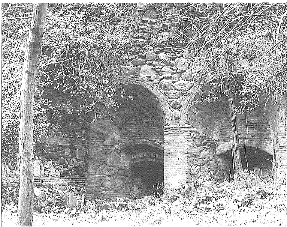
Part de la façana dels forns del ciment.
