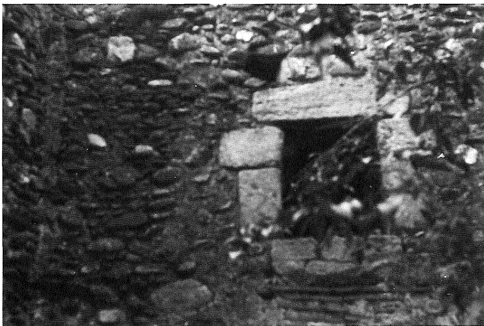
Can Martorell. Detall d'una vella finestra (Foto n.º 1)
