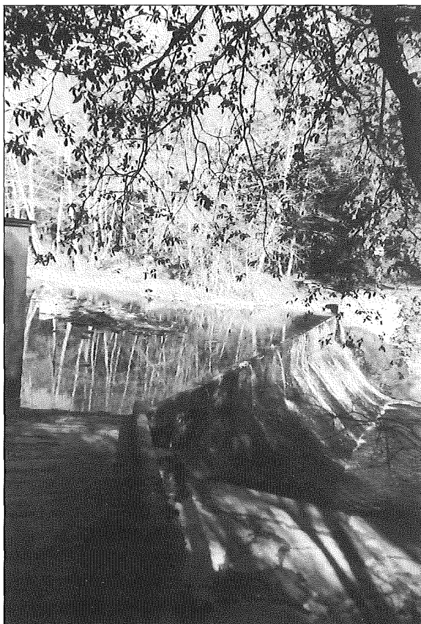
Moderna resclosa que ha substituït la que va originar el plet de 1722.
