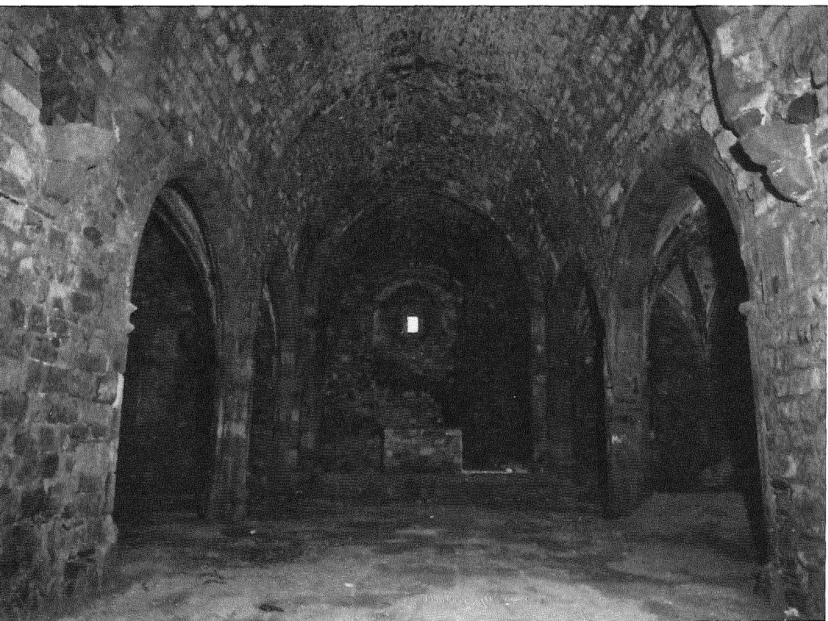
Interior de Santa Maria de Tagamanent, en curs de restauració. (Foto: Amics de Tagamanent.)
