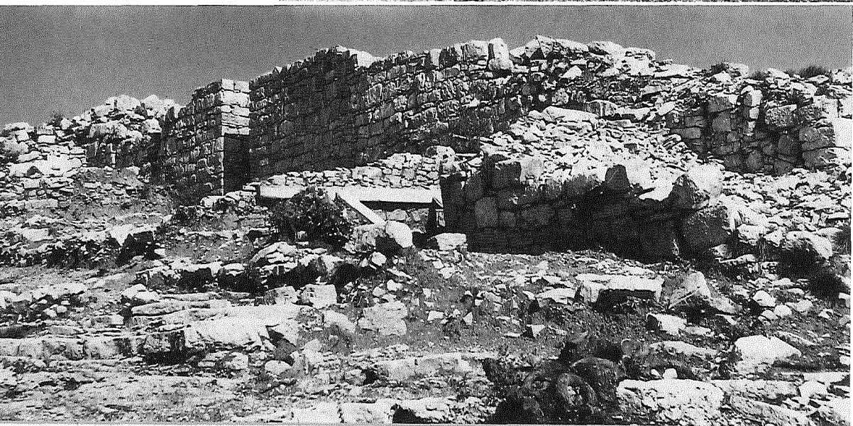
Aspecte de l'interior de la muralla, en part restaurada el 1988.
