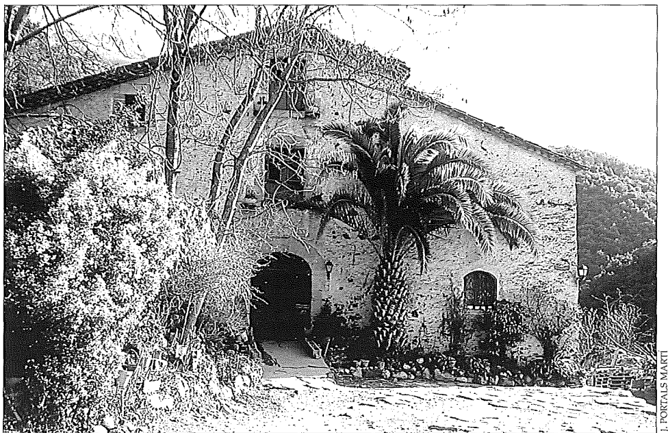
Can Riera Moliner, prop de l'actual central hidroelèctrica coneguda amb aquest nom
