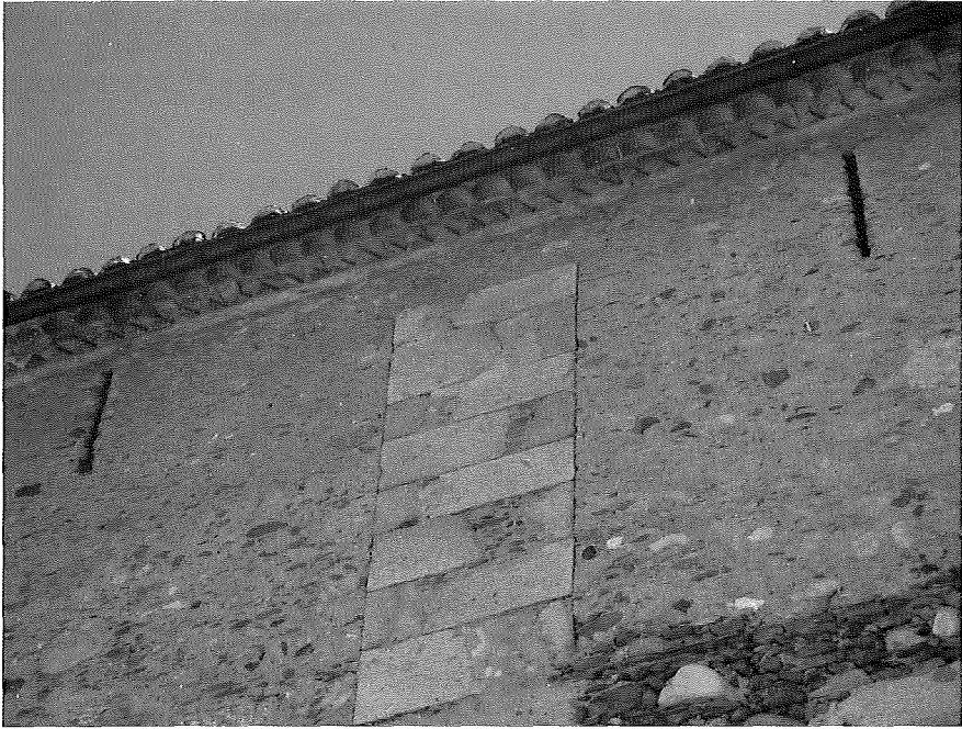
Encara són visibles dues espitlleres a un dels murs laterals de la Parròquia de Sant Martí de Sant Celoni.
