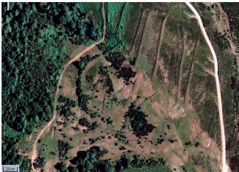
Ortofotografia del sector de la Calma on es localitza la Casa de la Neu; és a la part central dreta, on s'insinuen dos rectangles, el més petit correspon a la planta enrunada de la casa. Es detecten clarament els marges que limiten les feixes antigues. Font: Institut Cartogràfic i Geològic de Catalunya.
