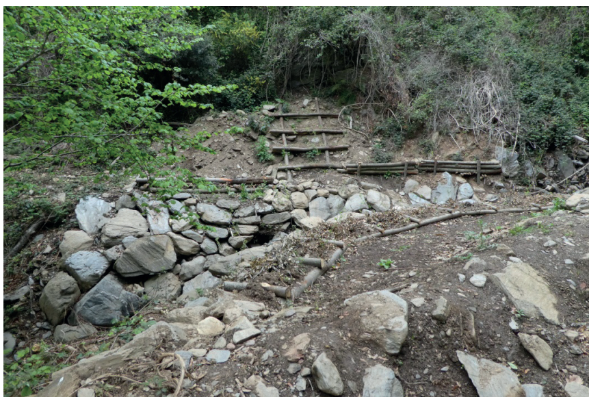
Per evitar l'erosió dels torrents per la manca de bosc i en conseqüència l'arrossegament de sediments al torrent, una de les solucions que s'han aplicat és la creació d'aquestes feixines que serveixen de base per plantar vegetació de creixement ràpid. (Foto arxiu PN Montseny).
