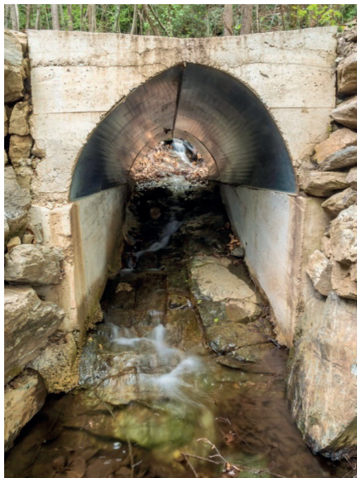
Solució tècnica permet construir un pas de fauna que conserva el pendent i l'estructura natural de la llera del torrent. (Foto Iñaki Relanzón).
