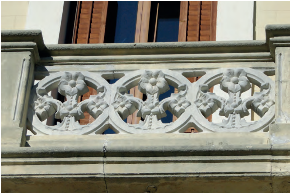
Balustrada o gelosia de la barana, amb decoració floral de traça modernista. (Foto J.M. Abril, Arxiu d'Imatges de Sant Celoni).
