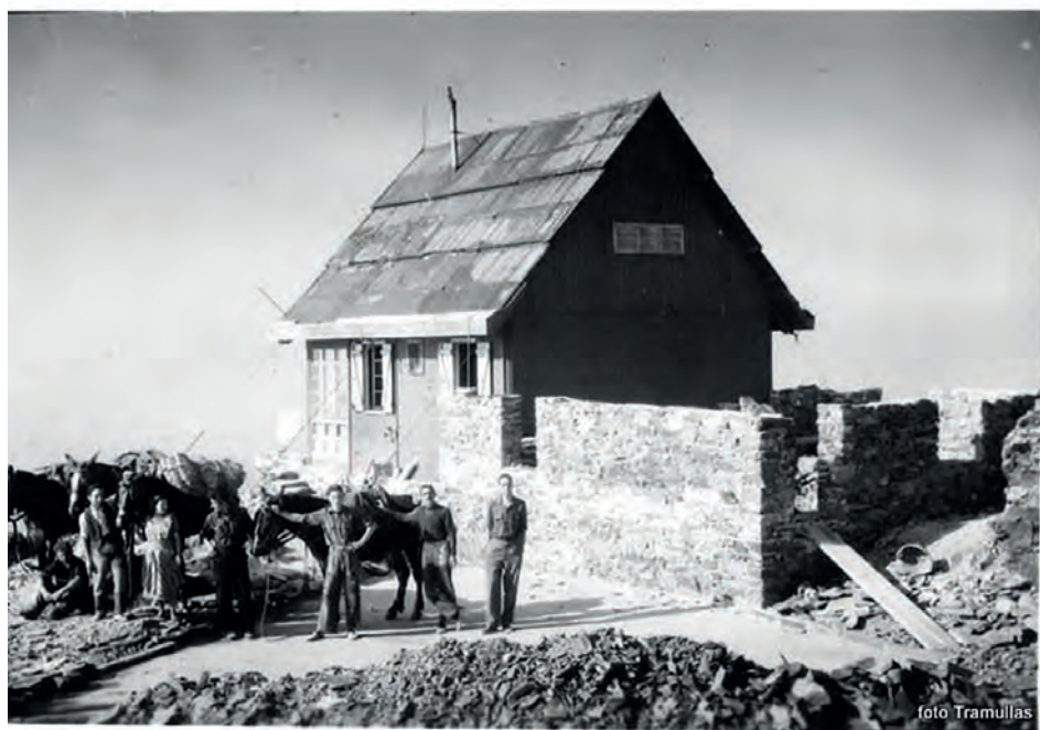
Construcció de l'ampliació de l'observatori, al 1954. (Foto Tramullas).
