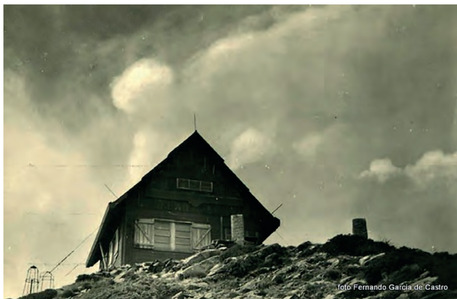
Façana sud de l'observatori del Turó de l'Home. (Foto F. García de Castro)
