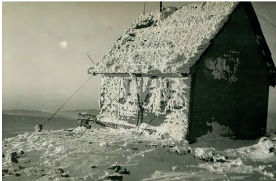
La caseta original de l'observatori del Turó de l'Home mirant al Vallès. (Foto A. Pressuto, F. García de Castro)
