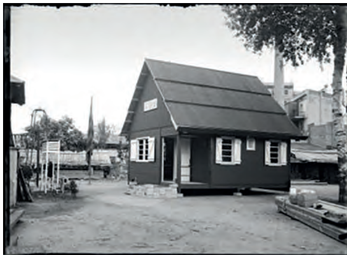
Caseta de fusta preparada per instal·lar-la al Turó de l'Home el 1932 com a habitatge per a l'observador.
