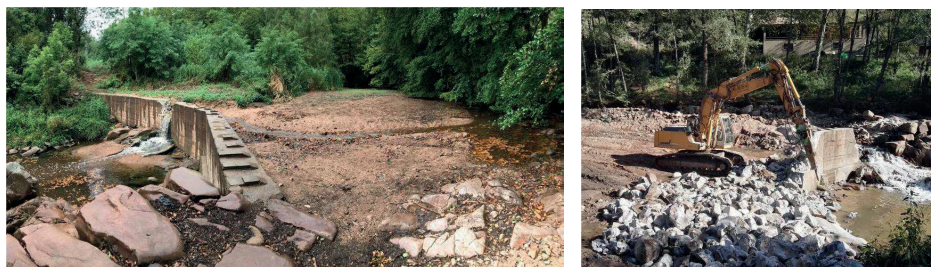
Figura 3. Resclosa del Molí de Bojons i material al·luvial, principalment sauló, que n'omplia el vas, abans del seu enderroc (esquerra). Fotografia durant l'enderroc de la resclosa (dreta). (Fotos Naturalea, 2018).
