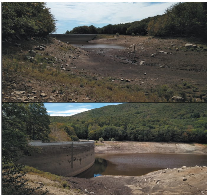
Figura 2. Estat de l'embassament de Santa Fe, agost del 2023. (Foto M. Fernández).
